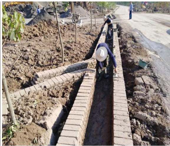
运矿道路两侧排水沟修建
