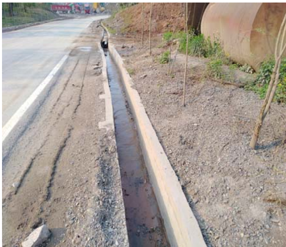
运矿道路硬化及排水沟
