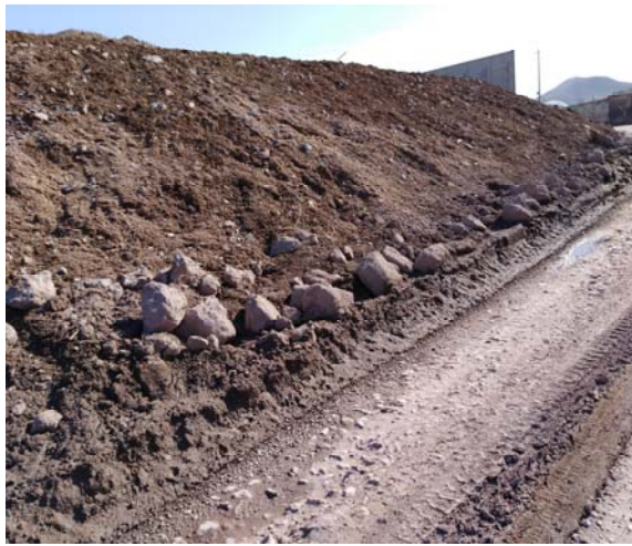
排土场未建挡墙前照片
