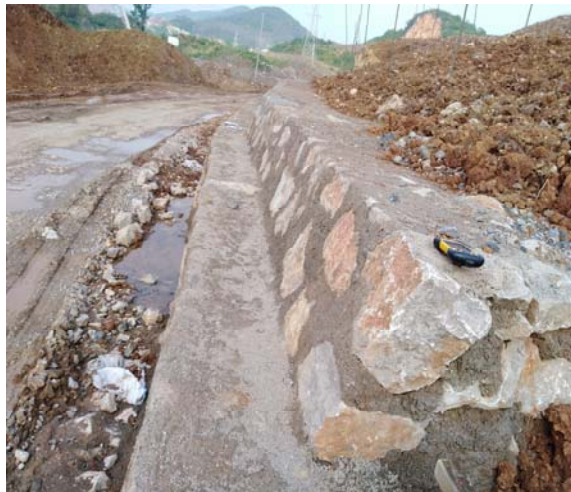
排土场挡墙现场照片
