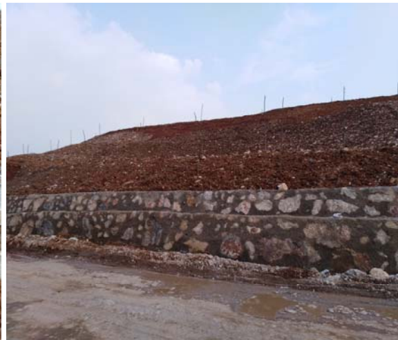
排土场挡墙现场照片
