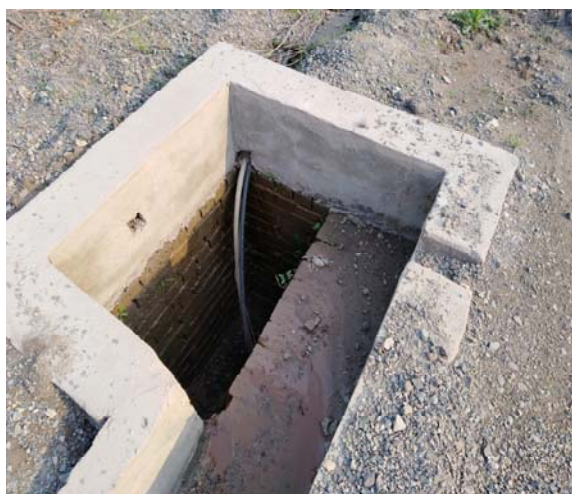
运矿道路排水沟布设的沉砂池
