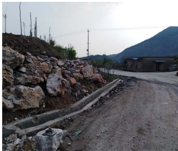
排土场干垒石拦挡现场照片
