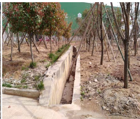
工业场地植物措施树木支撑
