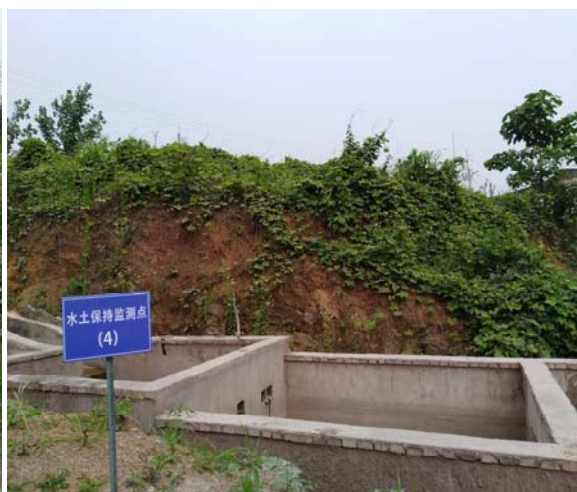
排水末端三级沉砂池
