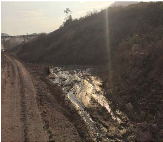
运矿道路未整治前照片
