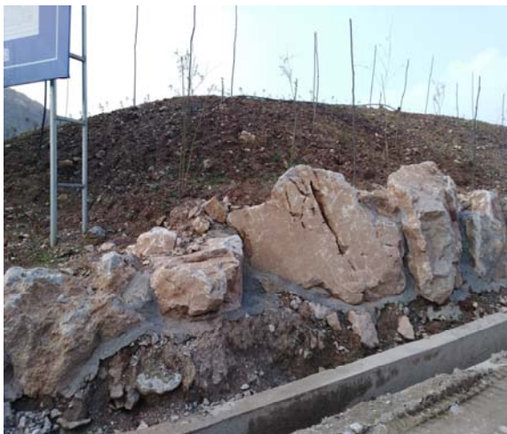
排土场干垒石拦挡现场照片
