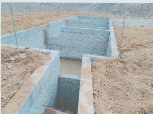
排水沟末端设大型三级沉淀池
