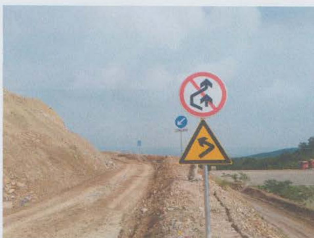
3 号运矿道路坡面原状
