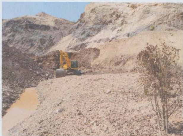
采矿区临时堆土坡面未撒播草籽前
