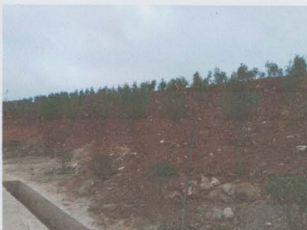
建设沿路排水及实施植物措施
