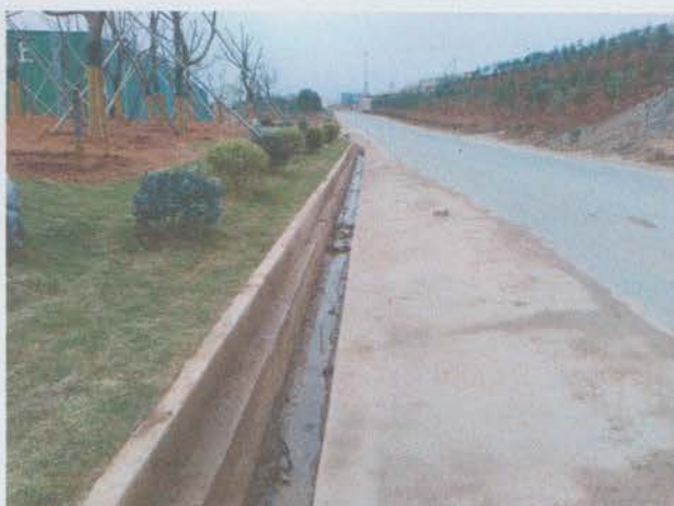
完成乔灌木植物措施
