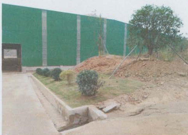
工业场地区设排水沟、乔灌木措施
