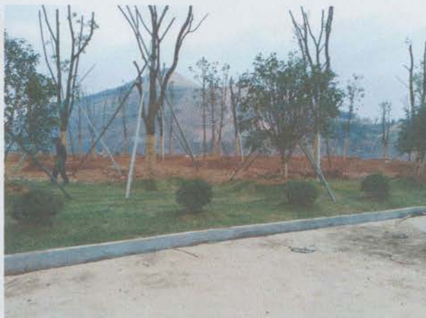
工业场地建设完成后周边绿化 (2)
