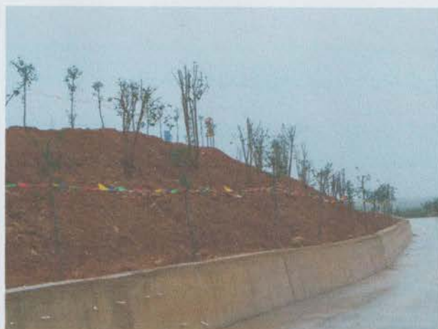
坡脚设挡墙、坡面撒播草籽、植乔木
