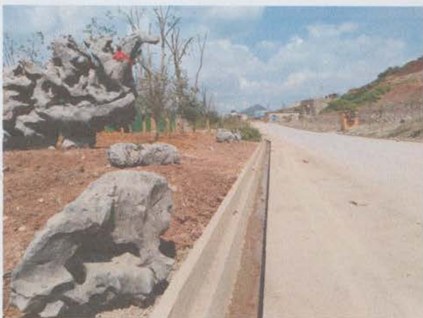
运矿道路边完成工程措施建设
