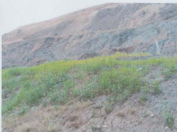
坡面撒播草籽后照片
