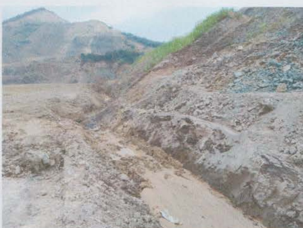
开挖土质排水沟（临时措施）
